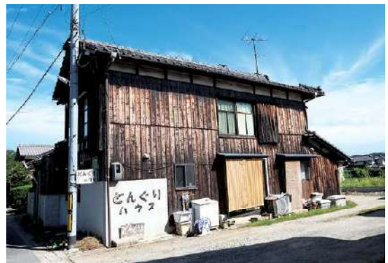
古民家を生かした趣のある建物
